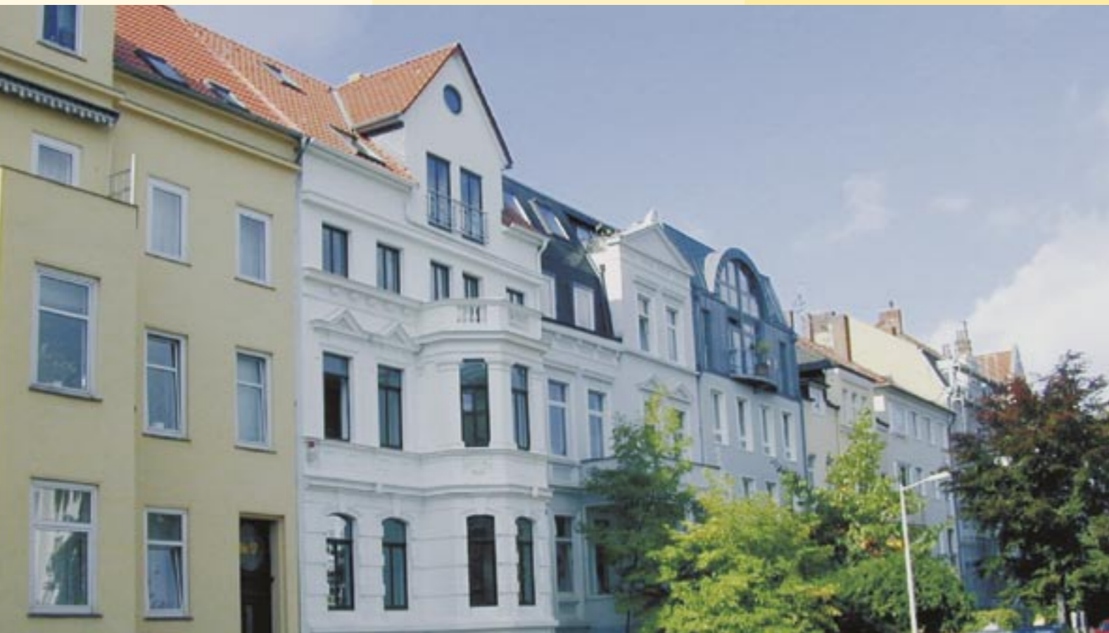
Gemäß Bundesimmissionsschutzverordnung (BImSchV) müssen Millionen von Heizungsanlagen erneuert werden.
